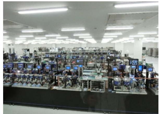
最新式空調設備のクリーンルーム
